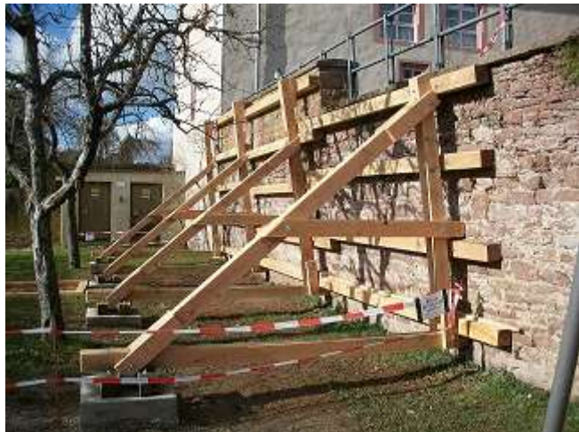
Massive Sicherung der Stützmauer beim Spielplatz
