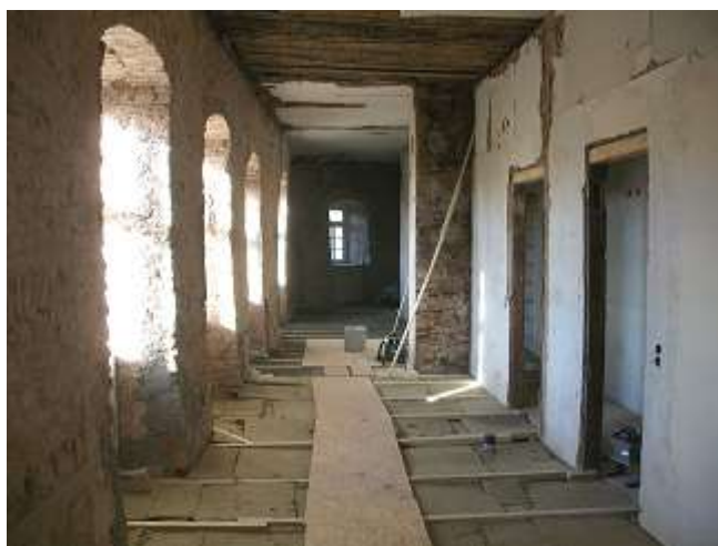
Kemenaten OG nach dem Auskernen
